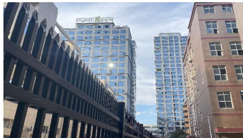
项目北侧：欣邦实业 4A 幢厂房，过厂房为诚大拉链厂房
