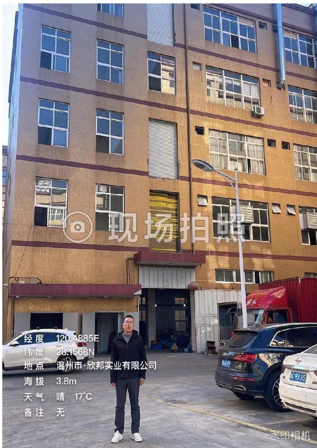
附图 1 编制主持人现场勘察照片
