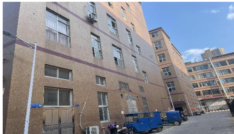
项目南侧：欣邦实业 4C 及 4D 幢厂房，隔厂房为永嘉县银瑞实业有限公司及众瑞服饰工业园厂房
