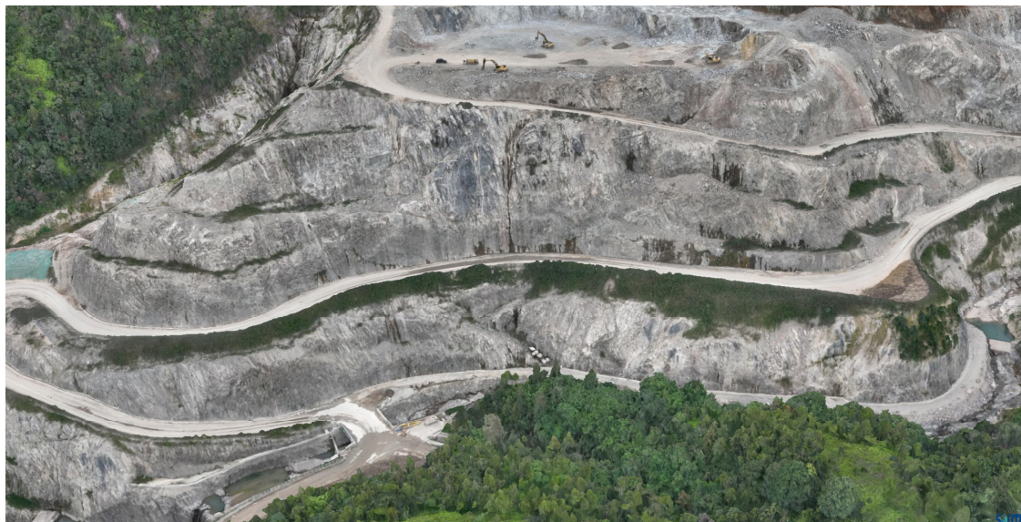
照片 3-2 道路边坡现状（俯视）
