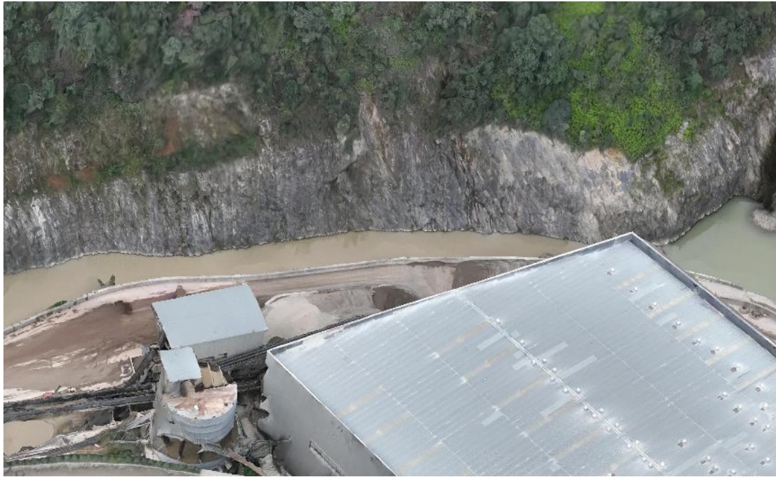
照片 3-4 工业场地（破碎加工场地）南侧边坡
