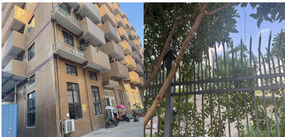
项目东北侧：欣邦实业厂区内其他建筑，隔河为其他企业厂房
