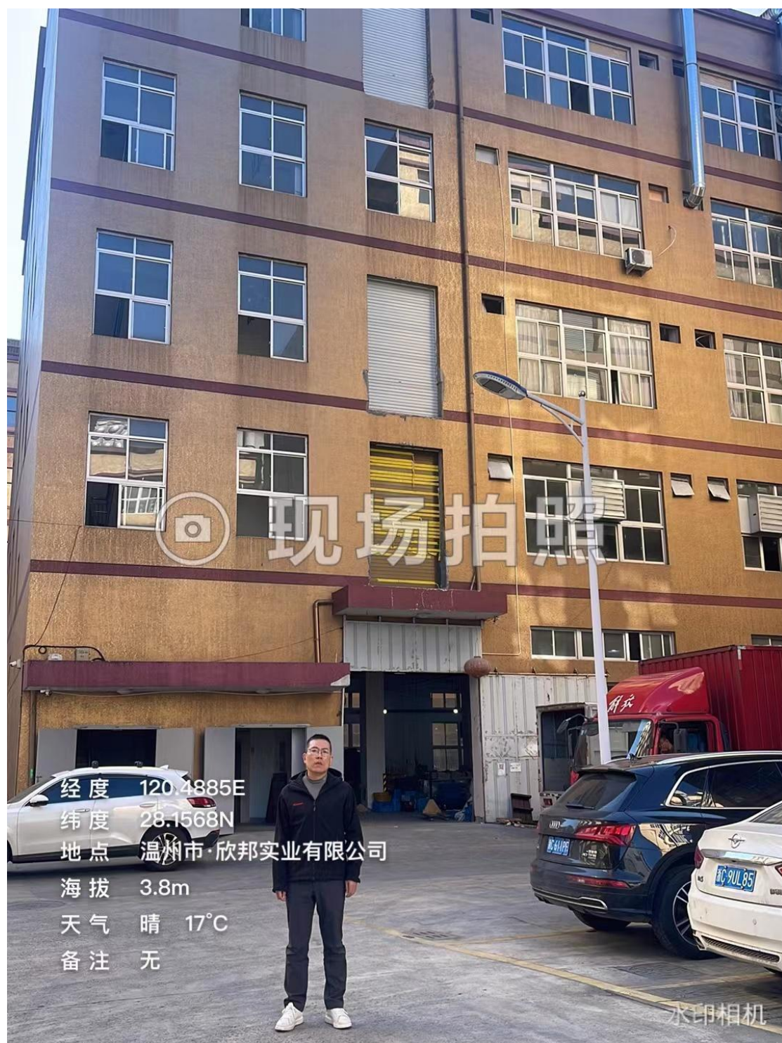
附图 1 编制主持人现场勘察照片
